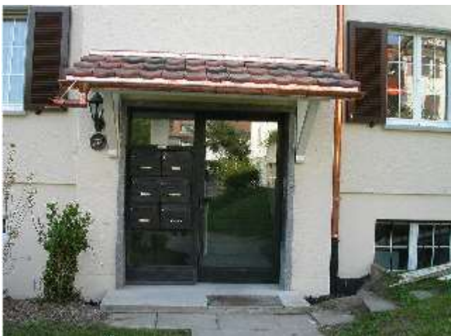
Hauseingang, Waldstr. 14, 8046 Zürich (1958)
