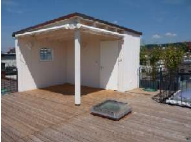
Dachaufbau. Dufourstr. 163, 8008 Zürich
