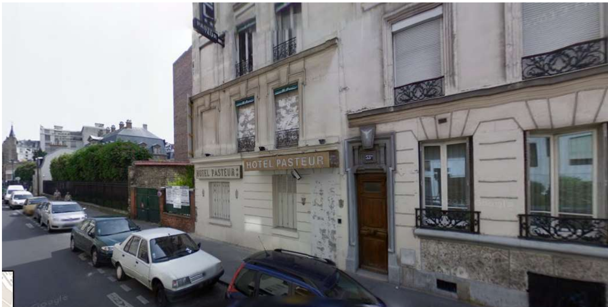
Ehem. Hôtel Pasteur, 33, rue du Dr Roux, 75015 Paris (2008)
